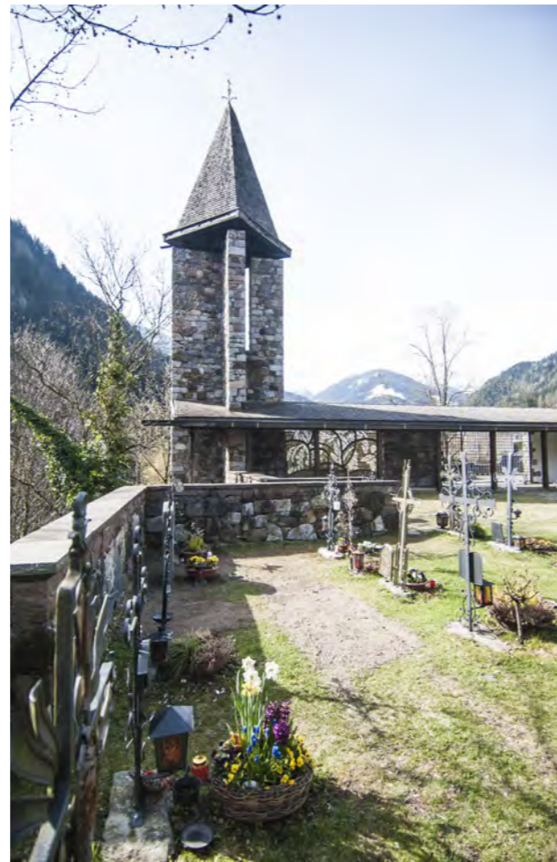
Eingangsbereich mit Auferstehungsfenster
