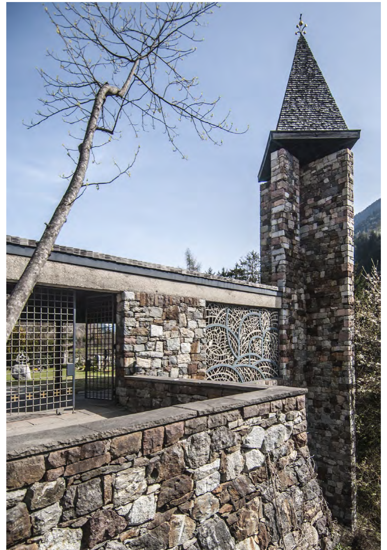
Stützmauern mit Glockenturm
