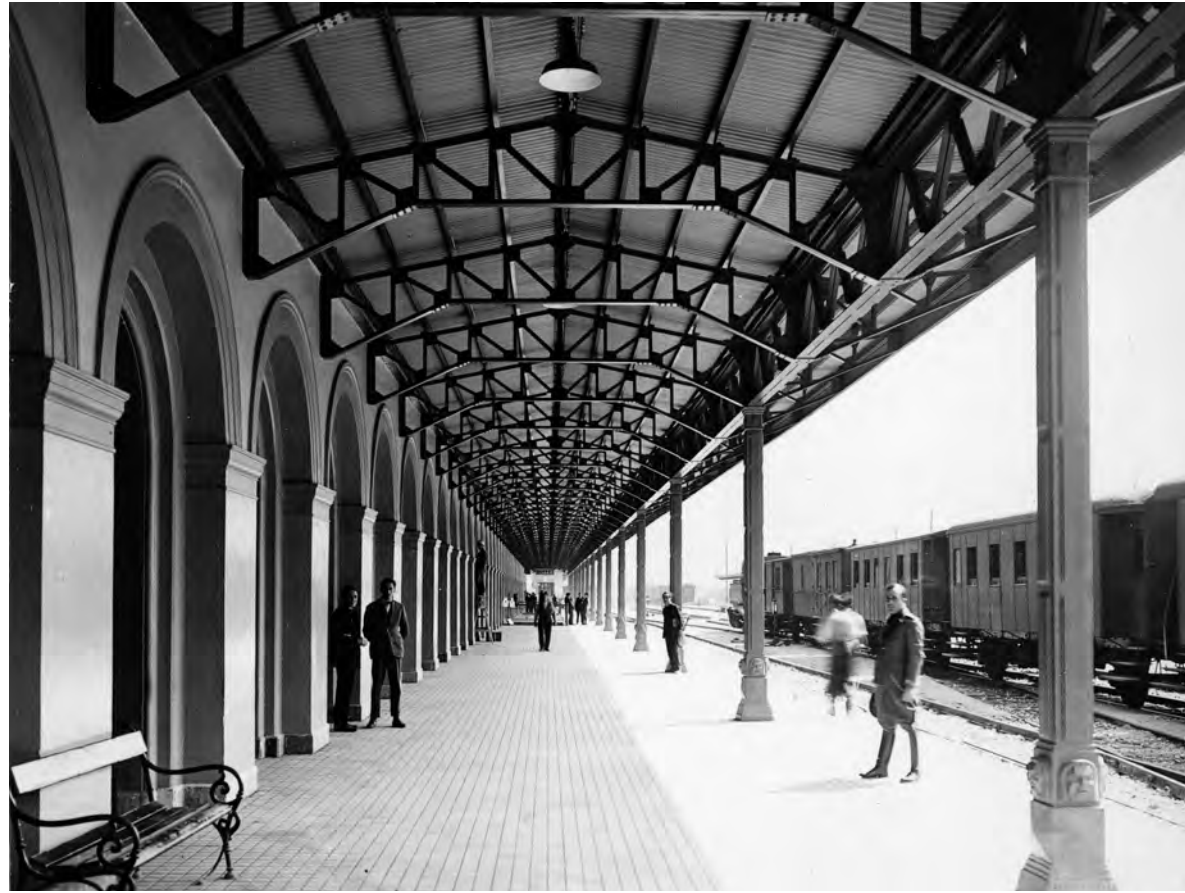
La nuova stazione di Bolzano, pensilina verso i binari 1928
