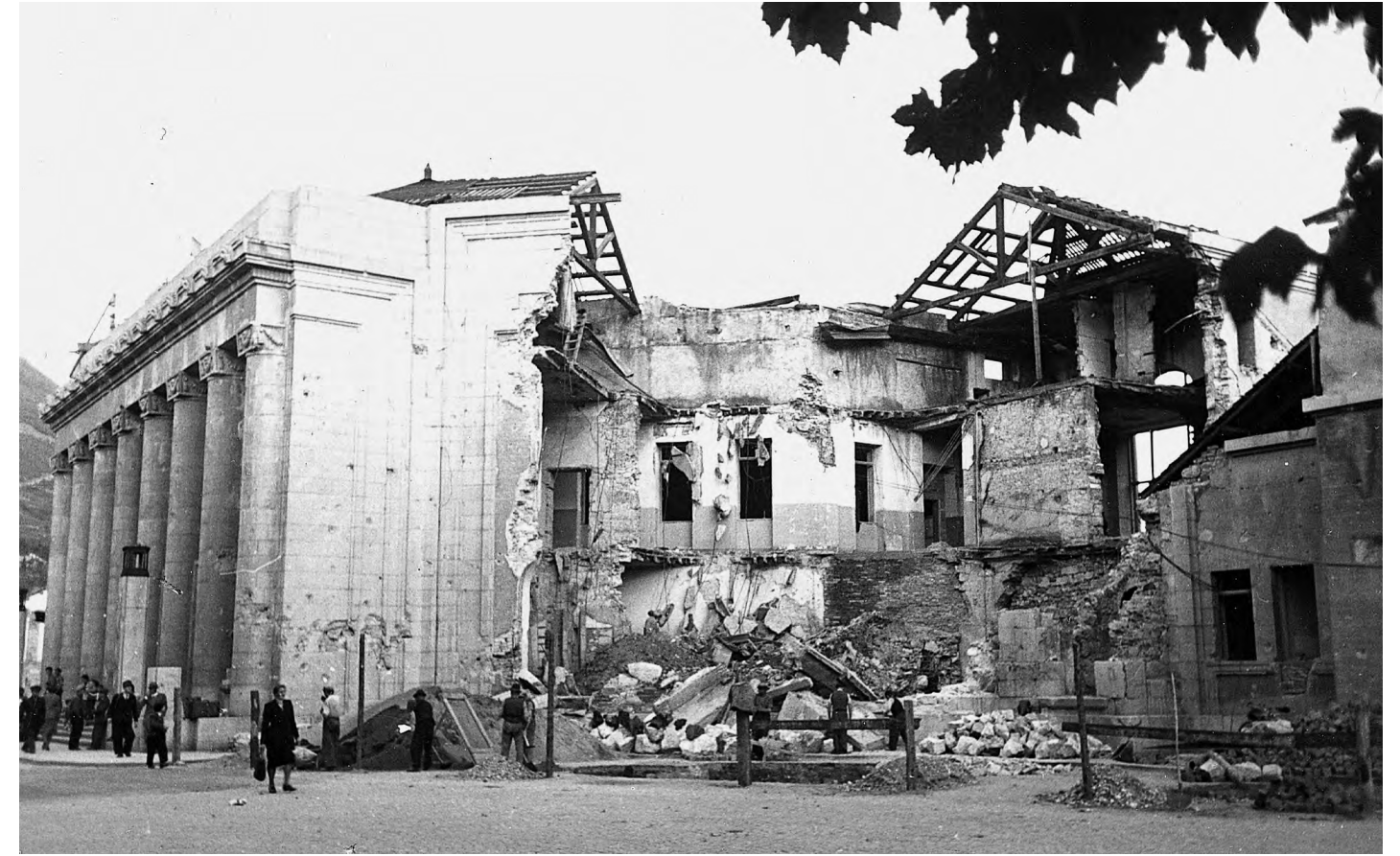
La stazione di Bolzano bombardata 1943
