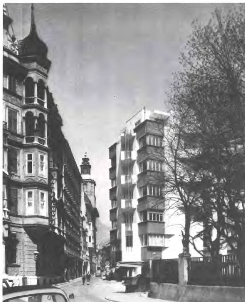
G. Dalla Bona, J. Zamolo Edificio in Via Grappoli, Bolzano
