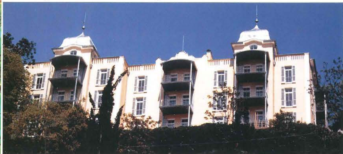
Sanierung - Ristrutturazione: Wohnanlage Ortenstein Meran - Merano
