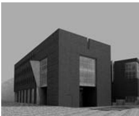
Il nuovo multisala in costruzione Foto: Carlo Calderan Rendering del progetto
