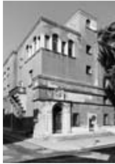
6 – Palazzo delle Poste (112)
