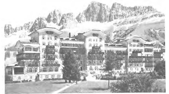
Karersee Hotel, nach dem Wiederaufbau 1912 (aus Schlern Nr. 3, 1926)
