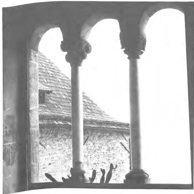
5. Ostpalas, Dreibogenöffnung in der Museumsverwaltung
