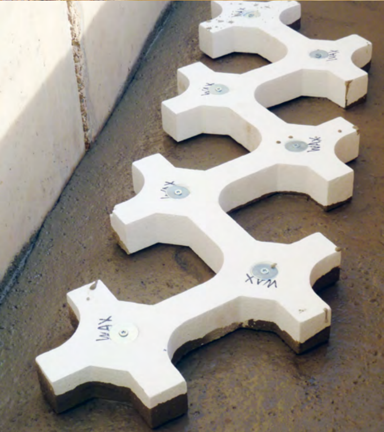
Einbau von mehreren tausend Körper in geformten Polystyrol zur Perforierung der Betondecke - Foto K. Goris
