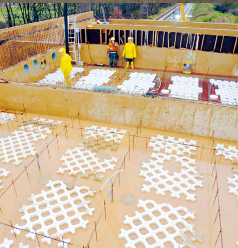
Einbau von mehreren tausend Körper in geformten Polystyrol zur Perforierung der Betondecke - Foto K. Goris
