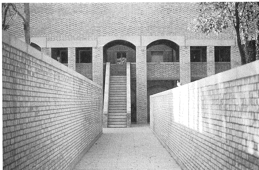
La "calle" di accesso principale
