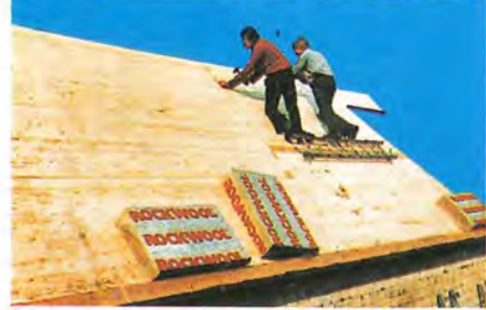
Die Sparren erhalten eine Vollschalung aus Nut- und Federbrettern oder Holzwerkstoffplatten.
