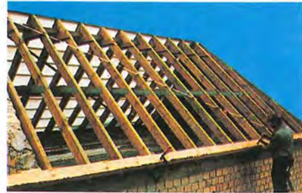
Die Traufkanthölzer bzw. Traufknaggen werden gemäß Systemstatik auf den Sparren befestigt.
