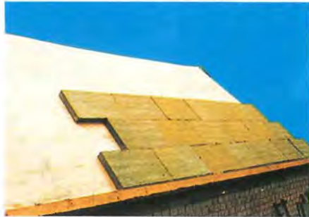
Die Traufkanthölzer bzw. Traufknaggen werden gemäß Systemstatik auf den Sparren befestigt.
