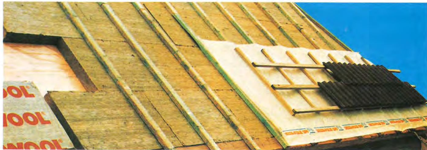
Abschließend erfolgt in gewohnter Weise die Verlegung der Dachlattung und die Dacheindeckung.
