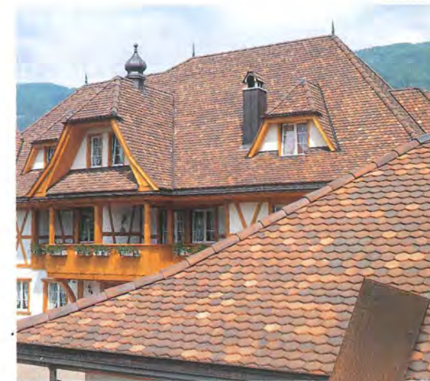
Biber 5 verschiedene Farben, 4 Schnitte (gerade, rund, spitz, gotisch)
