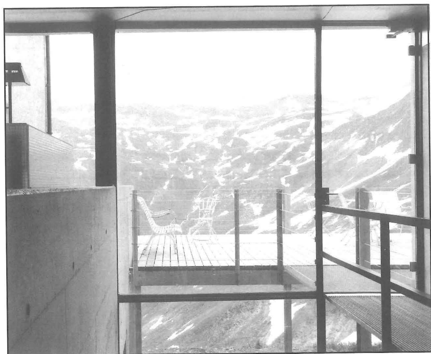
L'apertura rivolta verso la montagna vista dalla sala del nuovo ristorante
