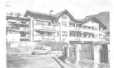
Wohngebäude in der Bäckerstraße (80er Jahre) Edificio d'abitazione in via Fornaio (anni '80)
