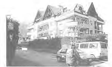
Wohngebäude in der Romstraße/Ecke Bäckerstraße (80er Jahre) Edificio d'abitazione in via Roma/angolo via Fornaio (anni '80)
