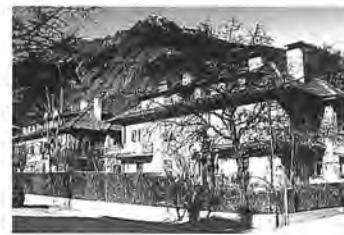
Häuser mit Walmdach in der Laurinsiedlung aus den 50er Jahren Case con tetto a padiglione nel complesso Laurino (anni '50)
