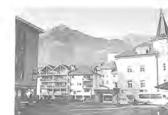
Theaterplatz, räumlicher Abschluß fehlt Piazza Teatro: manca la definizione spaziale
