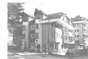
Wohnbebauung Ecke Petrarcastraße/Romstraße (90er Jahre)/Edificio per abitazioni angolo via Petrarca/via Roma (anni '90)
