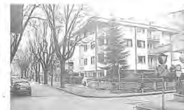
Wohngebäude in der 30. Aprilstraße (80er Jahre) Edificio d'abitazione in via 30 Aprile (anni '80)
