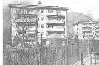
Wohnanlage in der Wolkensteinstraße (60er Jahre) Insedimento abitativo in via Wolkenstein (anni '60)
