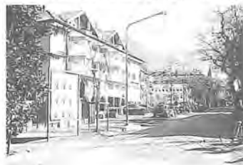
Wohn- und Geschäftsgebäude in der Freiheitsstraße, unmittelbar am Theater- platz (70er Jahre) Edificio per abitazioni e negozi in Corso Libertà verso Piazza Teatro (anni '70)
