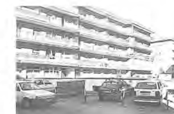
Wohnanlage in der Leopardistraße (60er Jahre) Insedimento abitativo in via Leopardi (anni '60)
