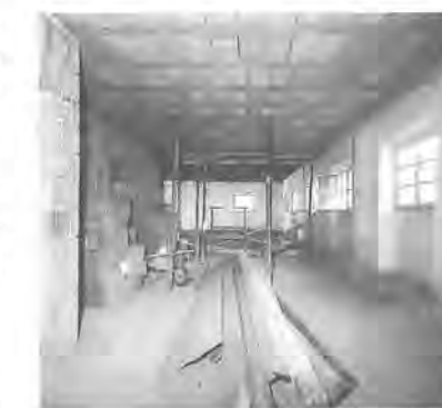
Die Ersetzung der historischen Decken im Angererhaus.
