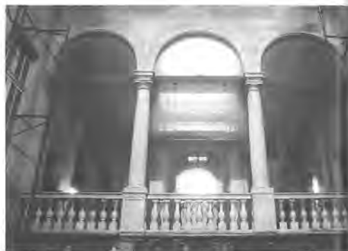
Palazzo Rosso, il sistema di grate che chiude le logge.
