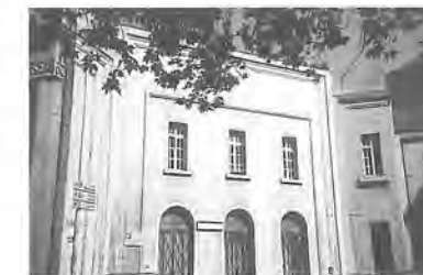
Bolzano, stazione ferroviaria: la facciata verso via Garibaldi ha le finestre originali al piano terra e "rinnovate" al primo piano.
