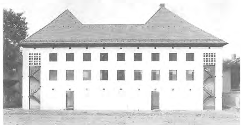
Altes Waisenhaus, die neue Nordfassade (1985-1988)
