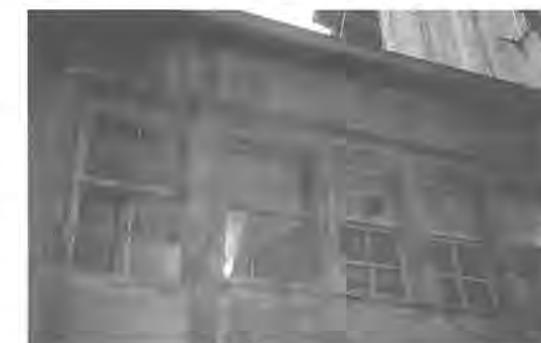
Bolzano, via Argenteria: finestre con cornici gotiche ed infissi ottocenteschi meritevoli di restauro.
