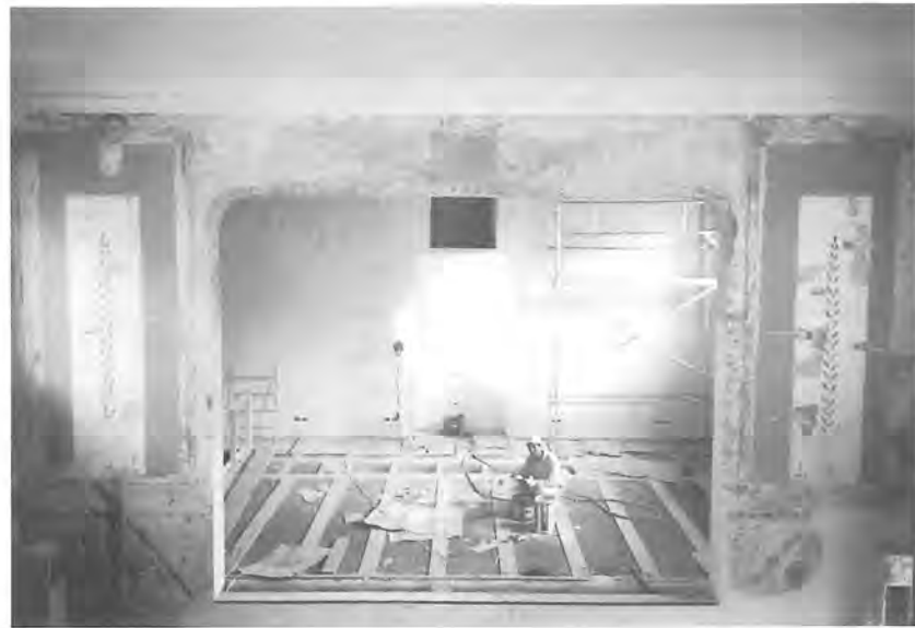
Die Wände vor und nach der Sanierung Rechte Seite oben: Galerie
