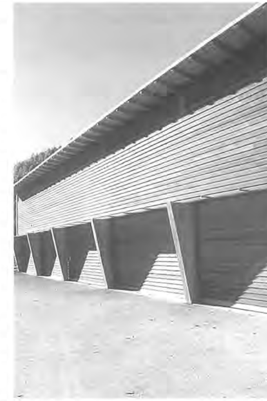
Landwirtschaftliche „Remise“ in Müstair. Die Holzfassade
