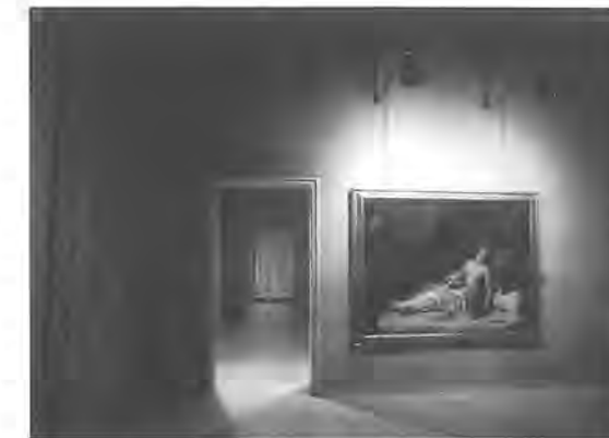
Palazzo Rosso, i proiettori alimentati da cavi in vista per non aprire tracce sulle pareti affrescate.
