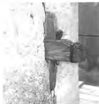
Zuganker aus Holz beim Feldthurnerhof.
