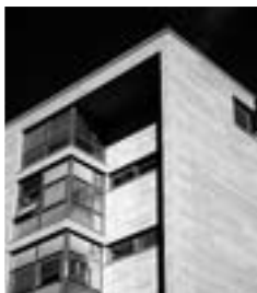
2000 – Paolo Bonatti Bürogebäude der Autonomen Provinz Bozen Südtirol, 1. Preis Architektur/Palazzo per uffici della Provincia Autonoma di Bolzano, 1° Premio Architettura
