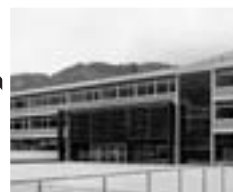
2002 – Siegfried Delueg Erweiterung der Landesberufsschule „Ch. J. Tschuggmall“ in Brixen, 1. Preis ex aequo Architektur/Ampliamento della scuola professionale provinciale "Ch. J. Tschuggmall" a Bressanone, 1° Premio ex aequo Architettura
