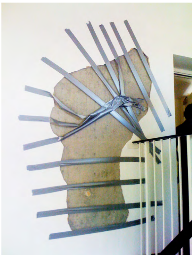
Rattoppo con nastro americano su un muro dal quale si era distaccato un grosso pezzo di intonaco
