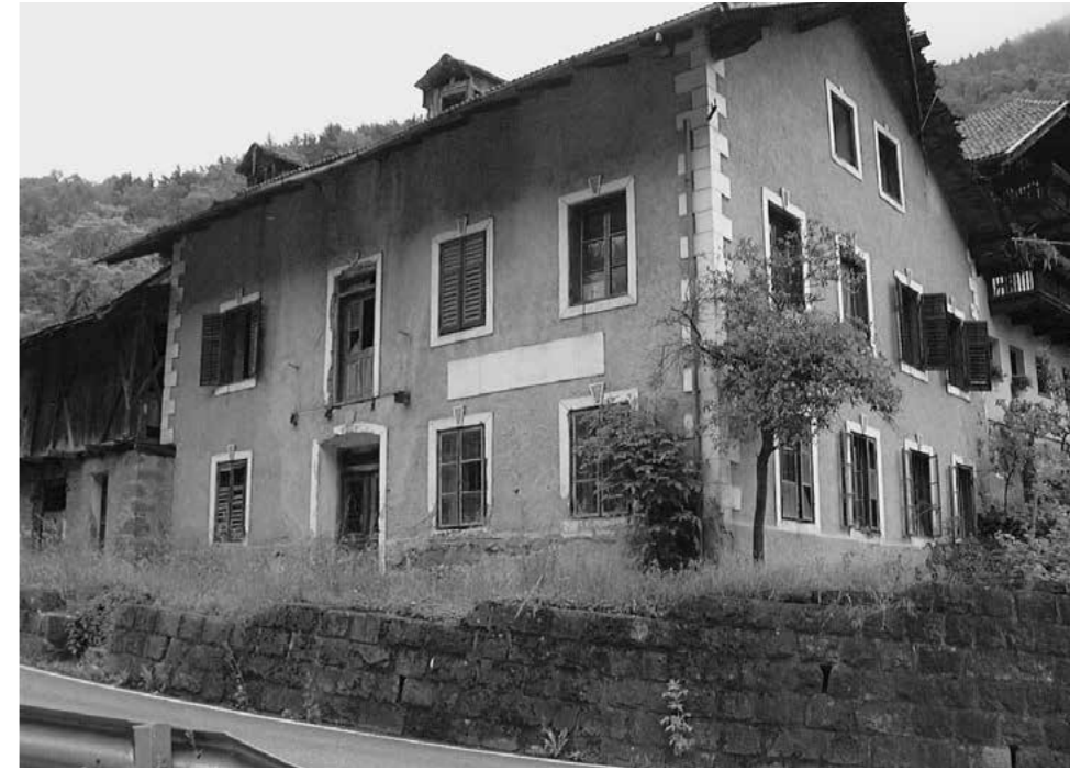
Halbweg Schulhaus vor Abbruch nach Schließung
