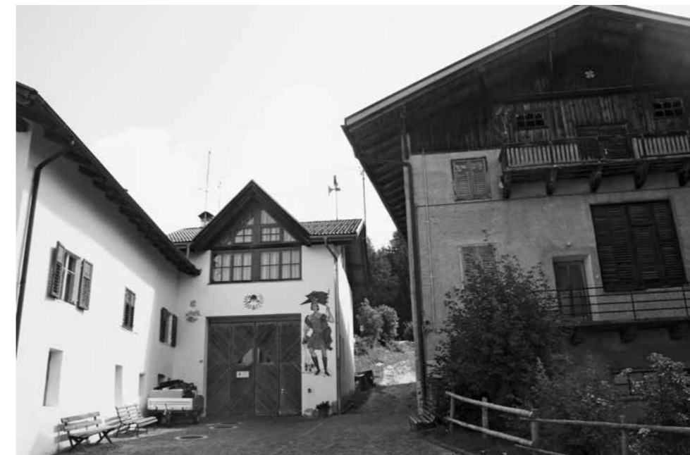
Gfrill Schulhaus heute als Feuerwehrhalle
